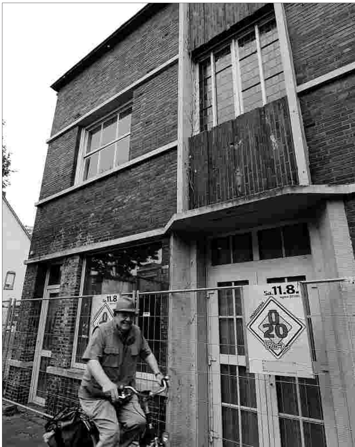
Das „Hotel Ernst“ in Palenberg ist seit der Vorstellung der „Städtebaulichen Sanierungsmaßnahme Wurmtal“ nun auch offiziell ein baulicher Missstand. Foto: Markus Bienwald
